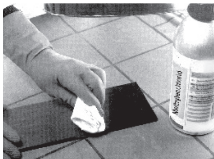
Abb. 13: Chemisches Nachbehandeln einer vorgeschliffenen Oberfläche
